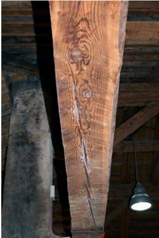
Un trave del sottotetto del Municipio di Lorenzago di Cadore. Nella pagina seguente i calchi delle sue crepe.
